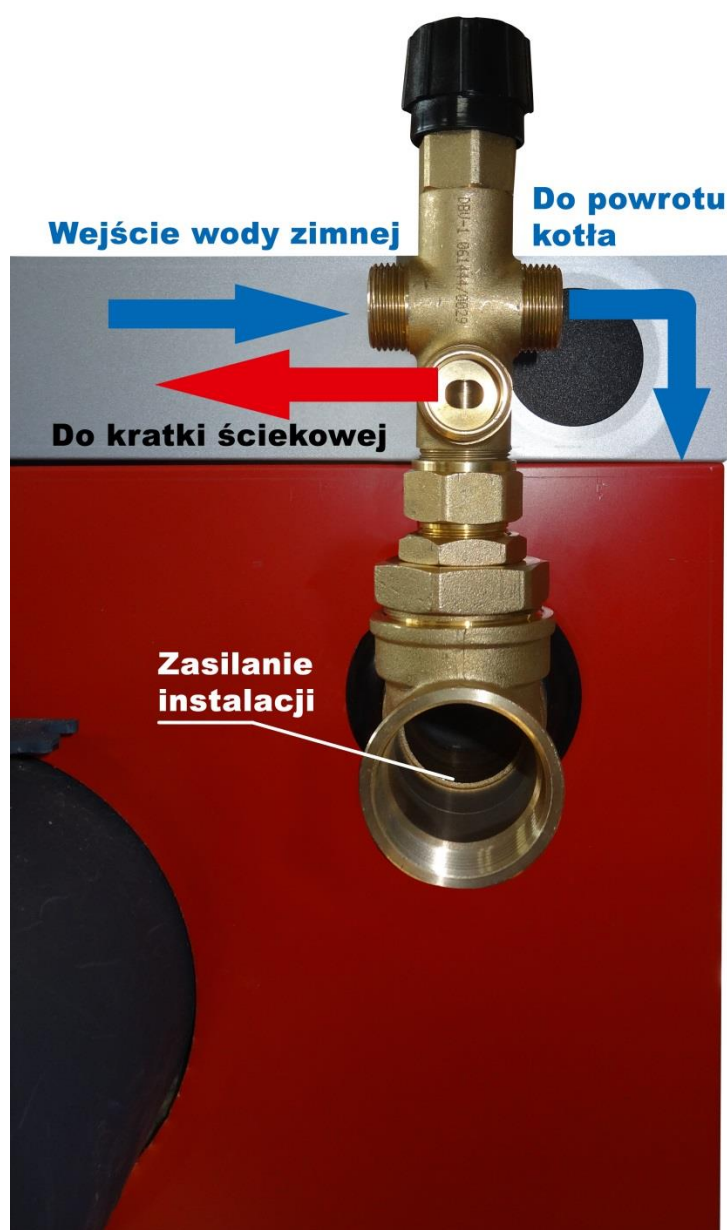
Rysunek - zasada podłączenia zaworu schładzającego DBV do kotła w układzie zamkniętym.
