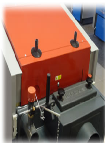
Pętla chłodząca przeciwko przegrzaniu
