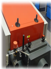
Pętla chłodząca przeciwko przegrzaniu
